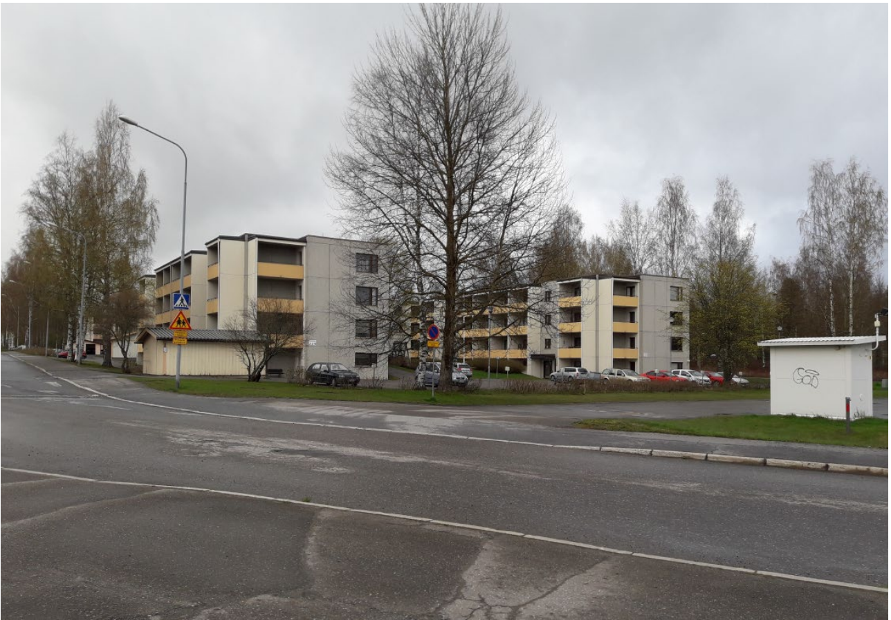
Kylmäseman takana olevaa kerrostalomassaa, kuvattuna Peitsarinkujalta.
