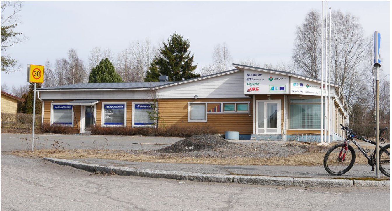
Pajakadun ja Juvantien kulmassa oleva liikerakennus. Rakennus on nykyisin tyhjillään.
