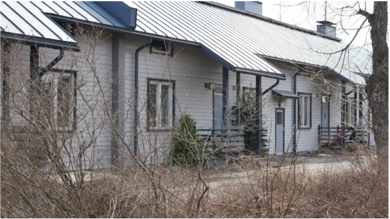
Rakennuksen julkisivua Pajakadun suunnasta.
