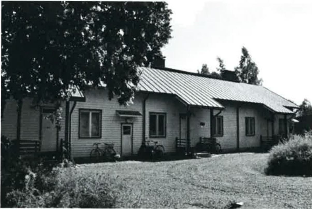
Kuva 4. Pajakadun rivitalon julkisivua (kuva rakennusinventointi).
